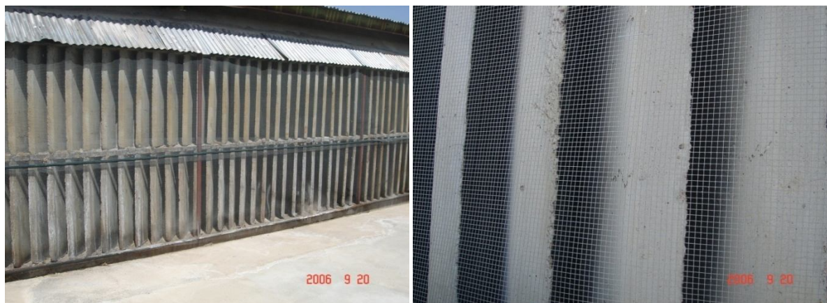
نمونه سیستم کولینگ پد برای سرد کردن سالن در تابستان در مرغداری‌ها
